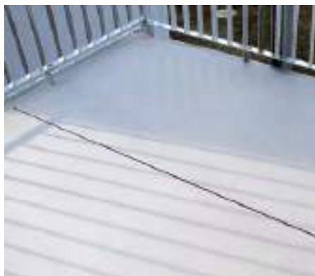
INCLINACIÓN Y UNIÓN DE PLACA
