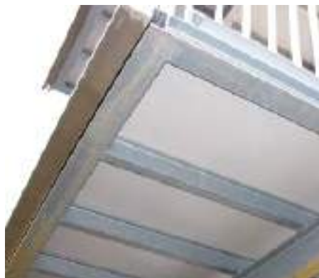
SUBESTRUCTURA/ELEMENTO DE SOPORTE
